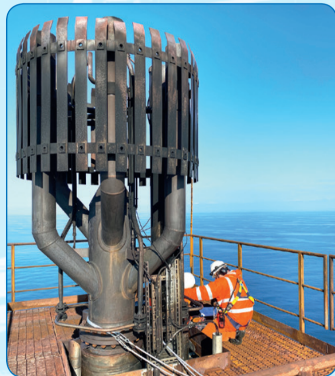
Электроработы в зоне факельного оголовка
