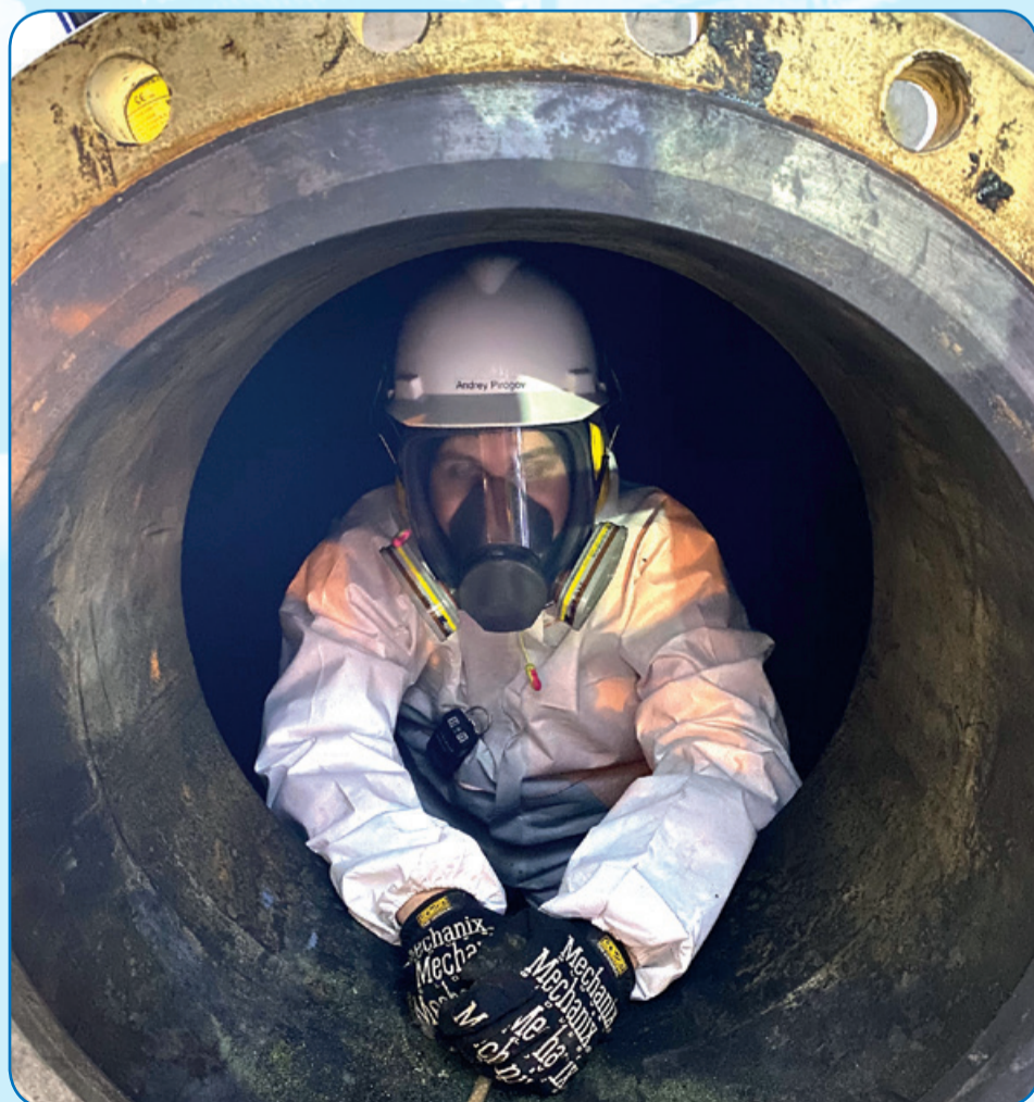
Работы в замкнутом пространстве
